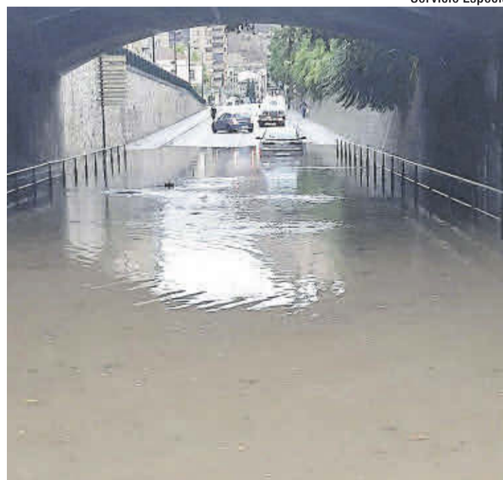
Anegado. Paso subterráneo de coches en Monzón, lleno de agua.
